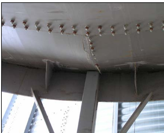
Рис. 14. Руйнування частини низькоміцних болтів в болтовому з'єднанні
