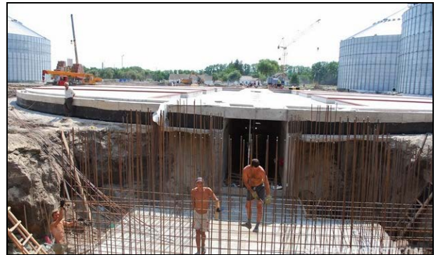
Рис. 10. Повторне влаштування фундаменту у зв'язку із виявленням його невідповідності проектній документації
