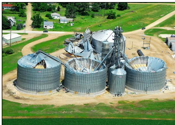
Рис. 3. Руйнування силосних комплексів
