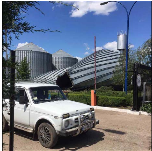
Рис. 5. Падіння силосу від вітрового навантаження
