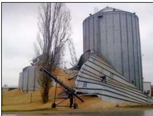
Рис. 2. Аварія сталевого силосу під час завантаження зерном
