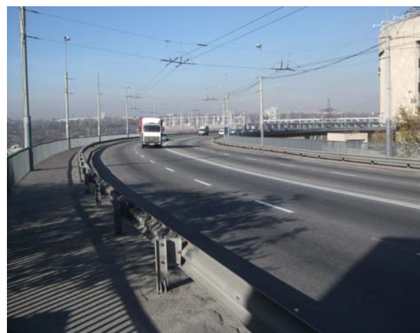
Рис. 1. Общий вид проезжей части эстакады
