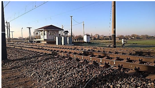
Рис. 2. Фото дослідної ділянки
