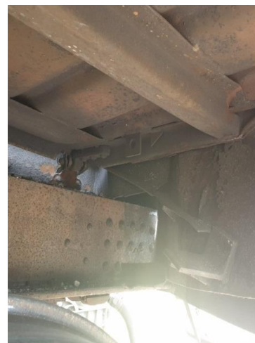
Рис. 1. Пошкодження рами піввагона: а – тріщина в хребтовій балці; б – відрив шворневої балки
