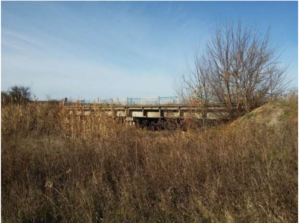
Рисунок 1.2 – Загальний вид мосту через р. Жовта у м. П'ятихатки
