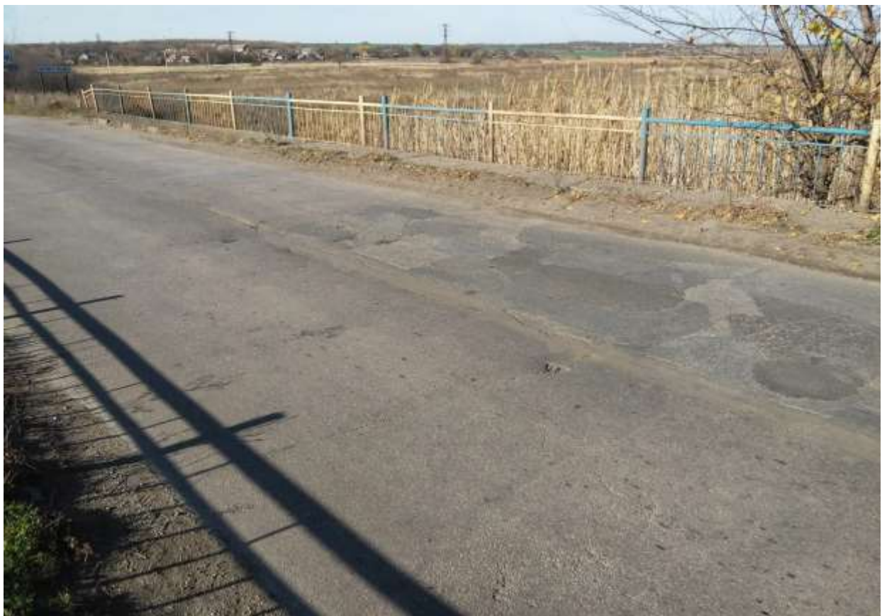
Рисунок 1.3 – Загальний вид проїзної частини мосту
