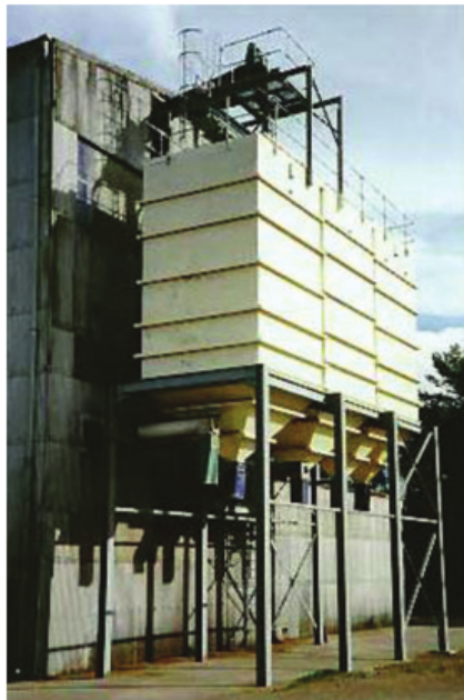
Рис. 1. Традиционная конструктивная схема с ребрами
