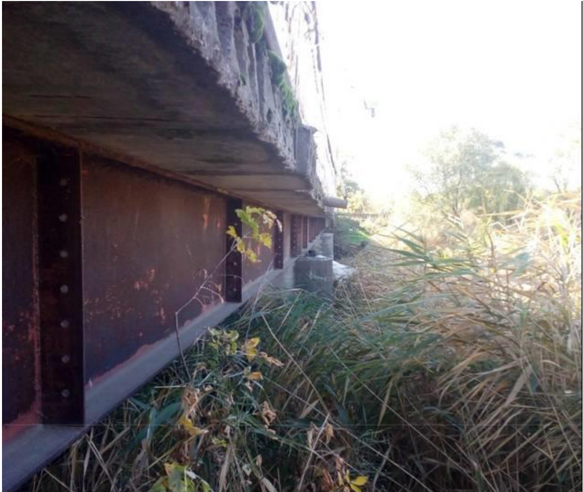
Рисунок 1.2 – Прогонові будови мосту. Вид с низової сторони
