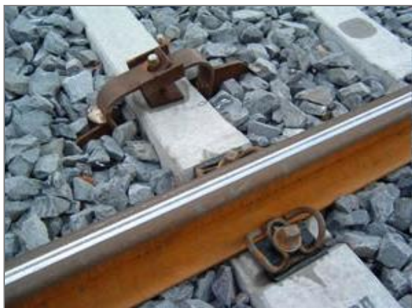
Рисунок 2.7 – Анкерування залізобетонної шпали по середині
