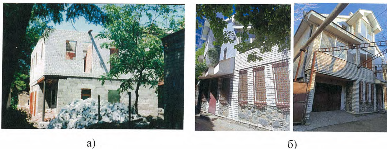
Рисунок 2.1 – Будинок: а) в процесі будівництва; б) загальний вигляд, 2024 р.
