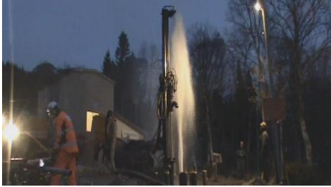
Рис. 1. Спеціальне обладнання для подачі холодоагента в підземні води ( https://www.geofrost.no/en/ )
