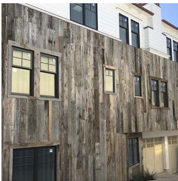
Рис. 3.27 - Приклад повторного використання дерев'яних дошок в оздобленні фасаду [62]
