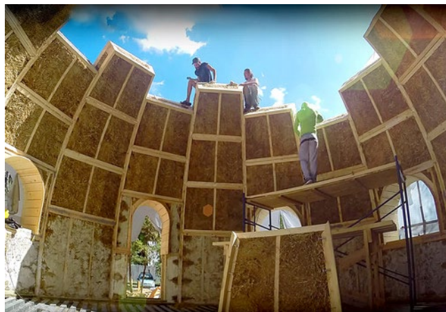
Рис. 3.12 - Теплоізоляція з соломи [49]
