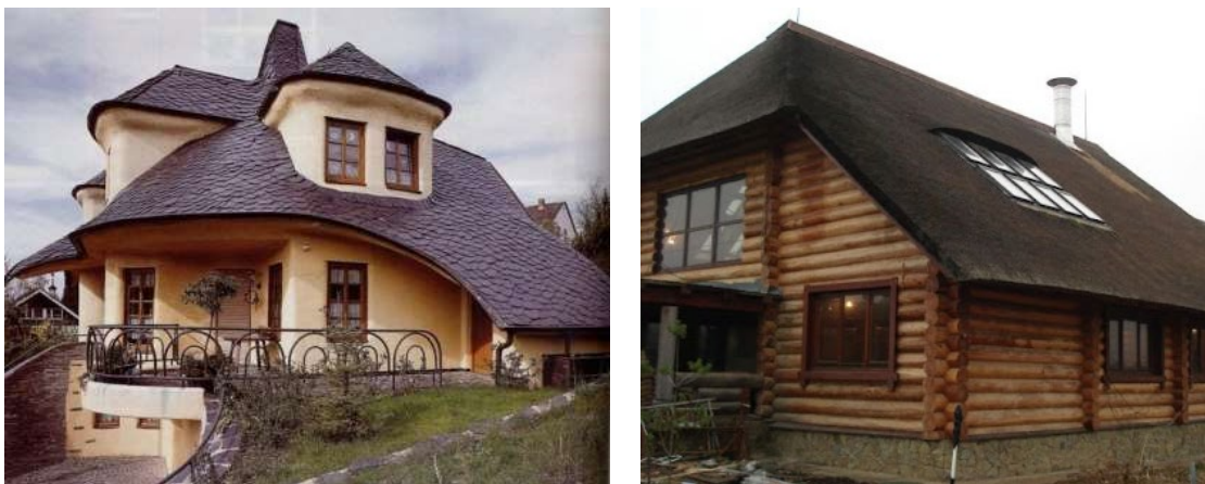
Рис. 3.26 - Фото сучасних індивідуальних будинків з матеріалів місцевого походження (саман - суміш глини з соломною, стіни з бруса, покрівля з очерету) [60, 61]
