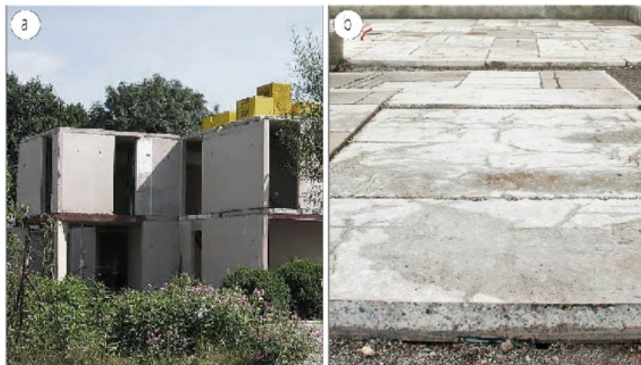
Рис. 3.24 - Апсайклінг бетону (повторне використання стінових панелей в дорожньому покритті) [57]
