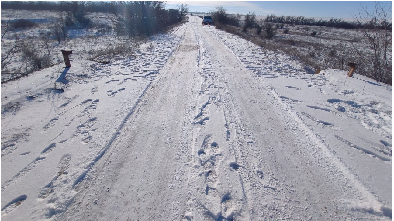
Рисунок 1.7 – Вид на проїзну частину підходу до мосту з боку м. Снігурівка
