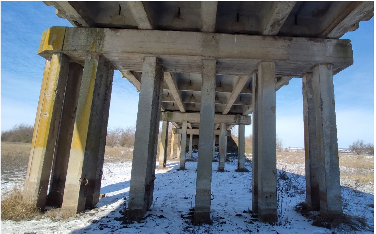
Рисунок 2.7 – Сліди вилуговування і діяльності мікроорганізмів на поверхні ригеля опори № 3.
