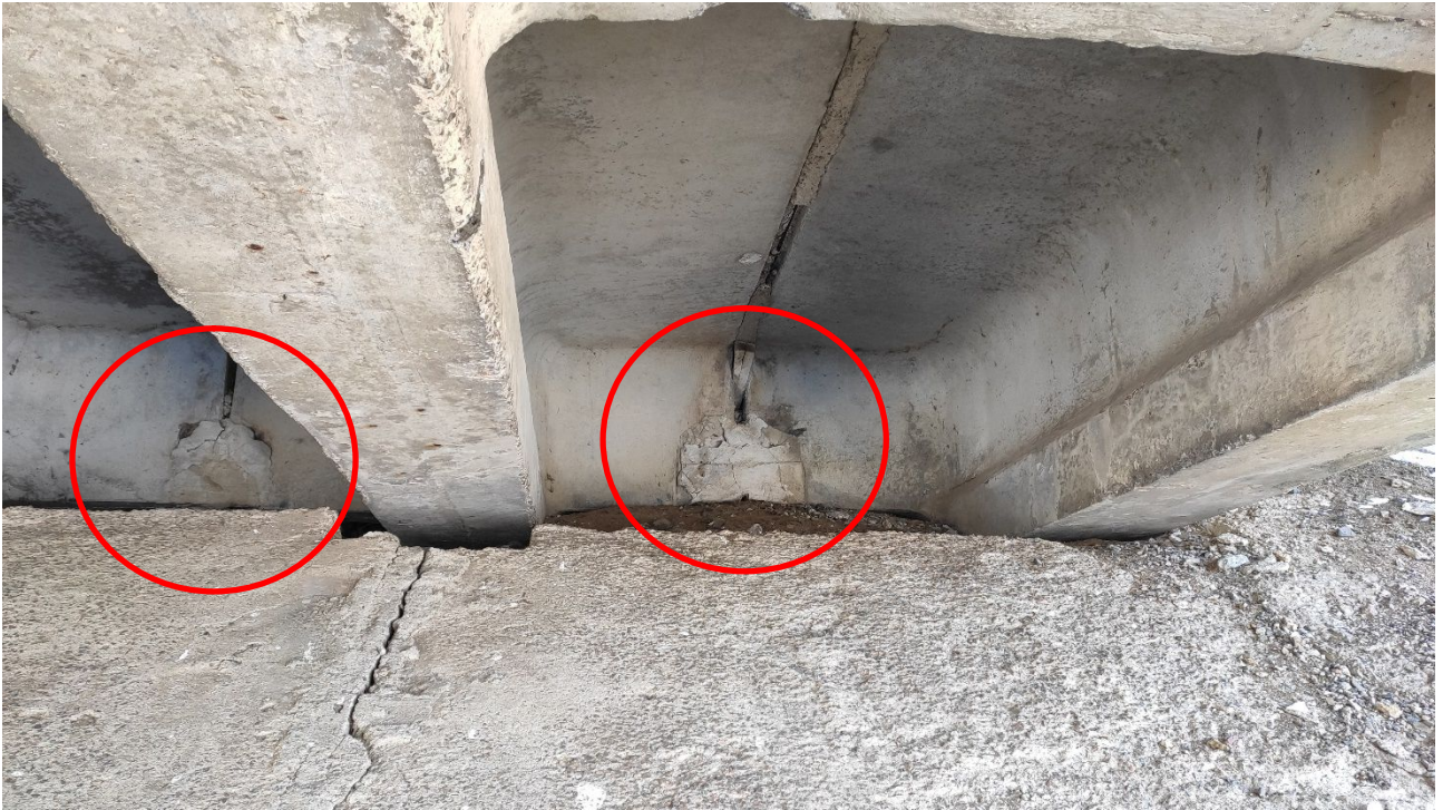
Рисунок 2.2 – Тріщини у захисному шарі бетону закладних деталей в об'єднаннях діафрагм між балками прогонової будови 0-1 над опорою №0.
