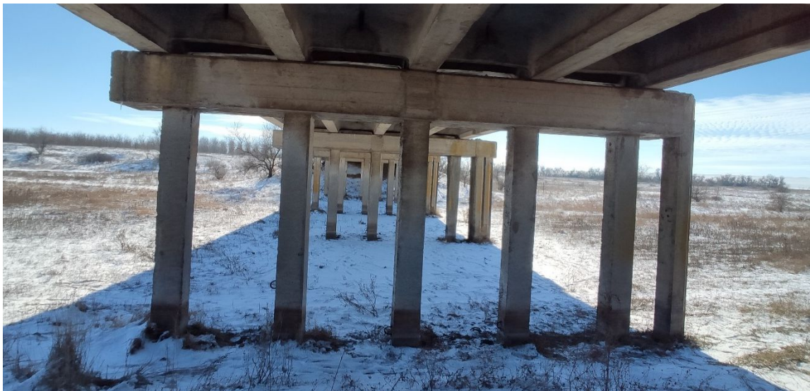
Рисунок 1.4 – Загальний вид проміжної опори № 1
