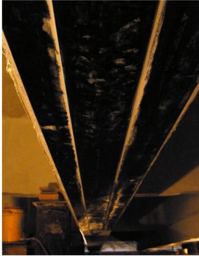
Рисунок 3.3 – Фото посилення прогонової будови стрічками Sika
