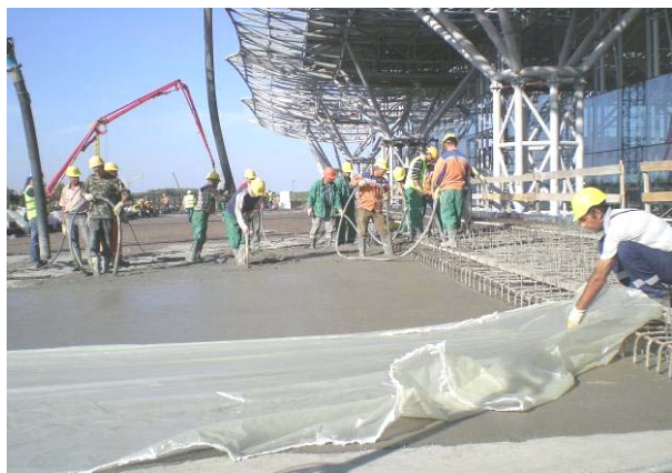
Рис. 5. Устройство паровлагонепроницаемого покрытия
