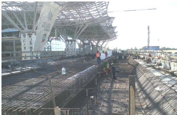
Рис. 2. Подготовка захватки пролетного строения к бетонированию
