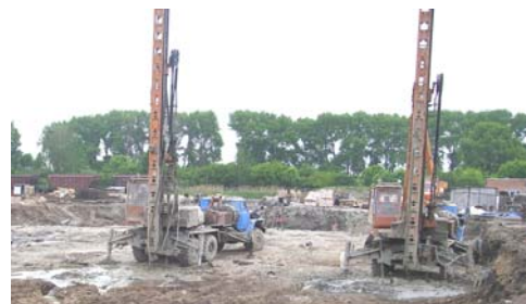
Рис. 2. Влаштування вертикальних ґрунтоцементних елементів на майданчику будівництва
