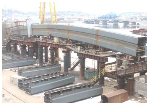
Рис. 1. Укрупнение элементов блоков арки. Строительство Подольского мостового перехода
