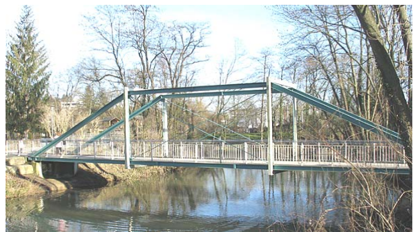
Рис. 2. Комбінований металевий мостовий перехід, Німеччина
