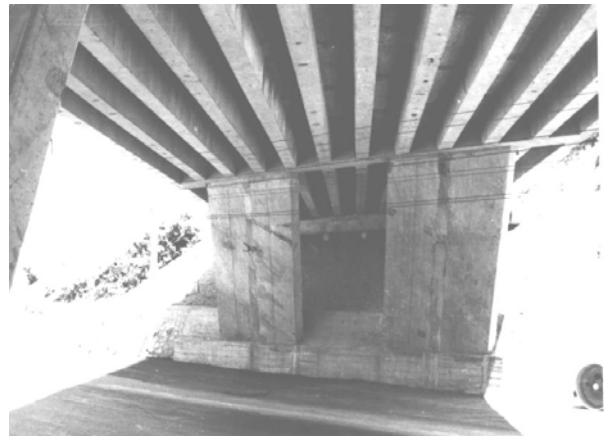
Рис. 2. Вид на пролётное строение снизу
