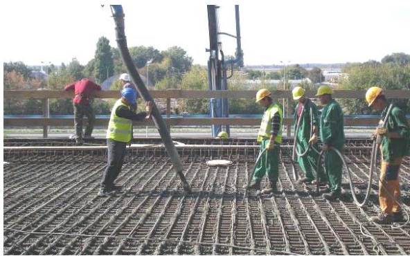
Рис. 4. Бетонирование захватки пролетного строения
