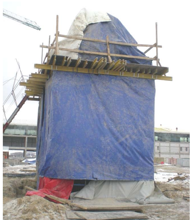
Рис. 6. Устройство тепляка колонны
