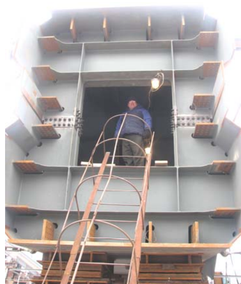
Рис. 2. Поперечное сечение арки
