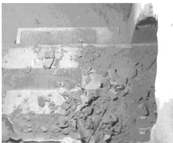
Рис. 5. Вид установки после взрывания шпуров в уступной части
