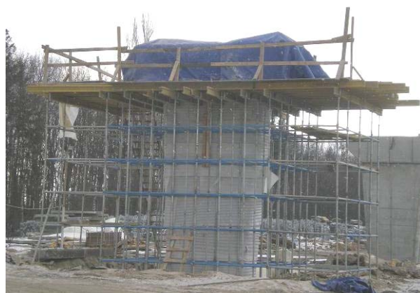
Рис. 7. Устройство тепляка капители
