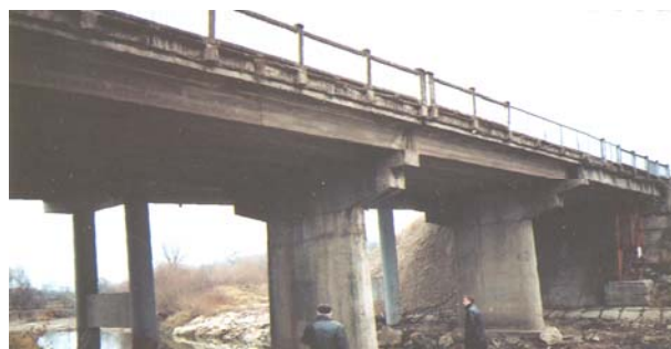
Рис. 2. Загальний вид існуючого моста
