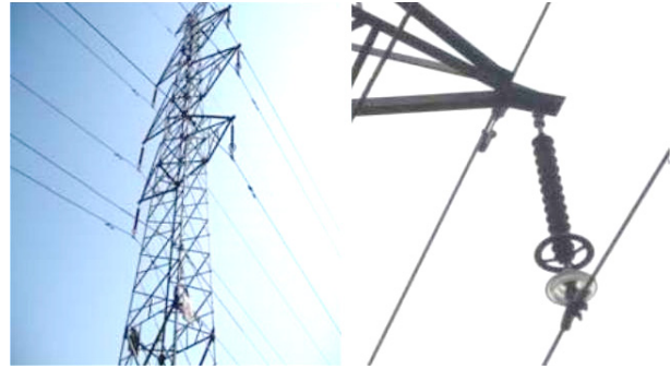
Рис. 2. ВЛ 110кВ, Shabao (Китай), полимерный изолятор с экраном и стеклянным изолятором
