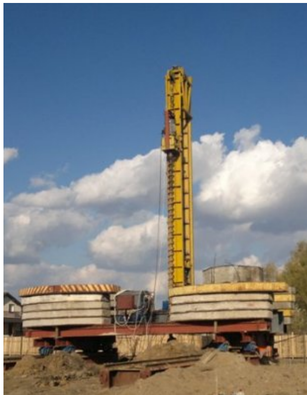
Рис. 1.22 Обладнання для вдавлювання паль
