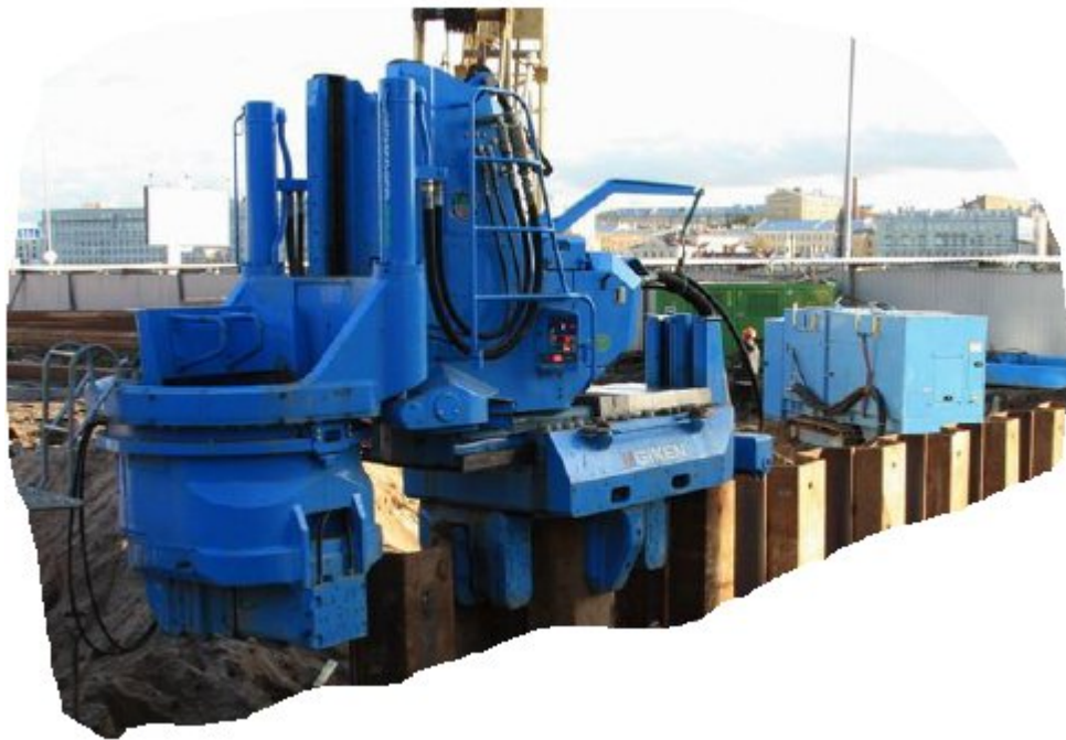
Рис. 1.23 Обладнання для вдавлювання шпунту
