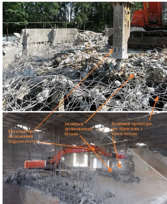
Рисунок 1.3 – Демонтаж залізобетону за допомогою гідромолоту (наглядно показані залишки арматури)
