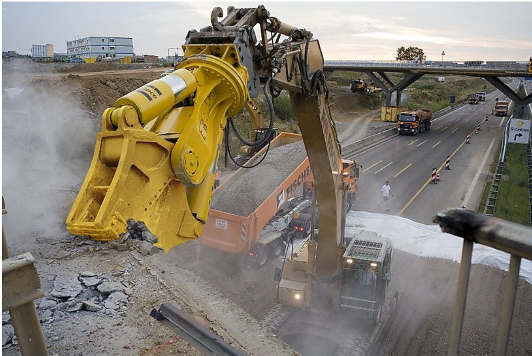
Рисунок 1.4 – Демонтаж залізобетону за допомогою гідрножиць
