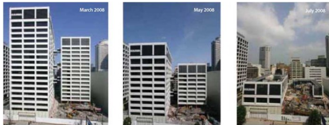
Рисунок 1.9 – Демонтаж за допомогою методу «Cut and Down»
