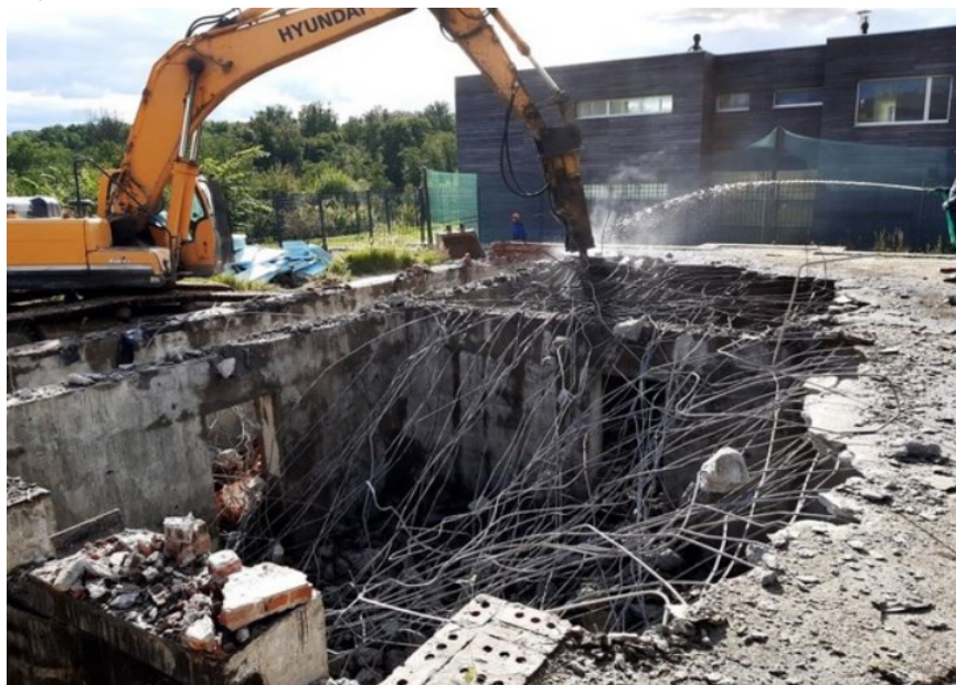
Рисунок 1.1 – Демонтаж плитної частини за допомогою гідромолоту
