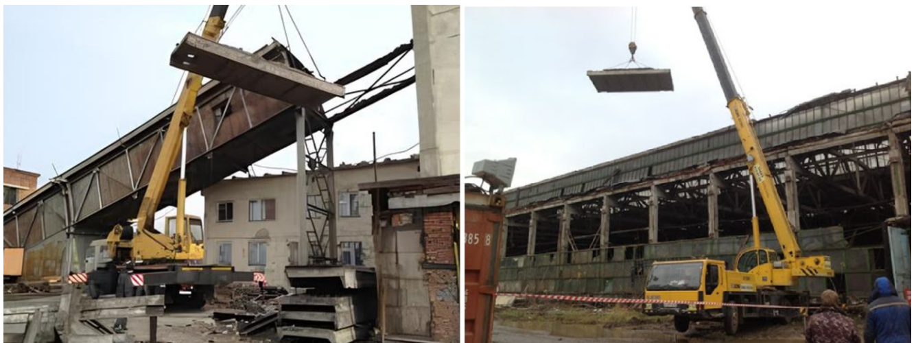
Рисунок 1.10 – Поелементний демонтаж плит краном
