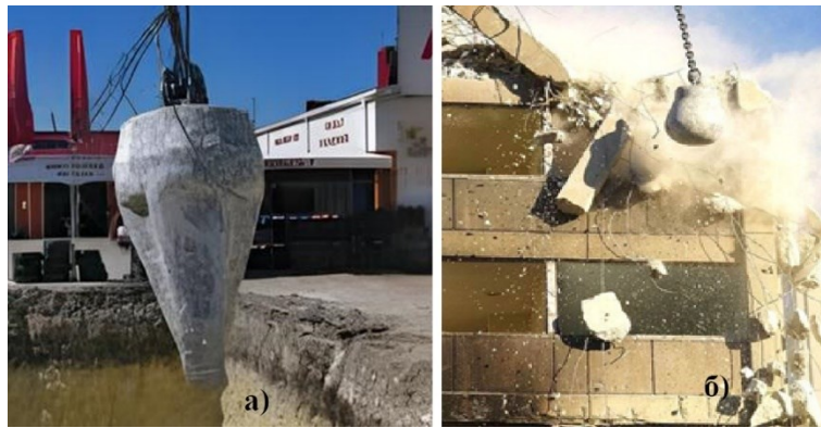
Рисунок 1.7 – Вигляд обладнання а) клин-молоту б) шар-молоту для демонтажу
