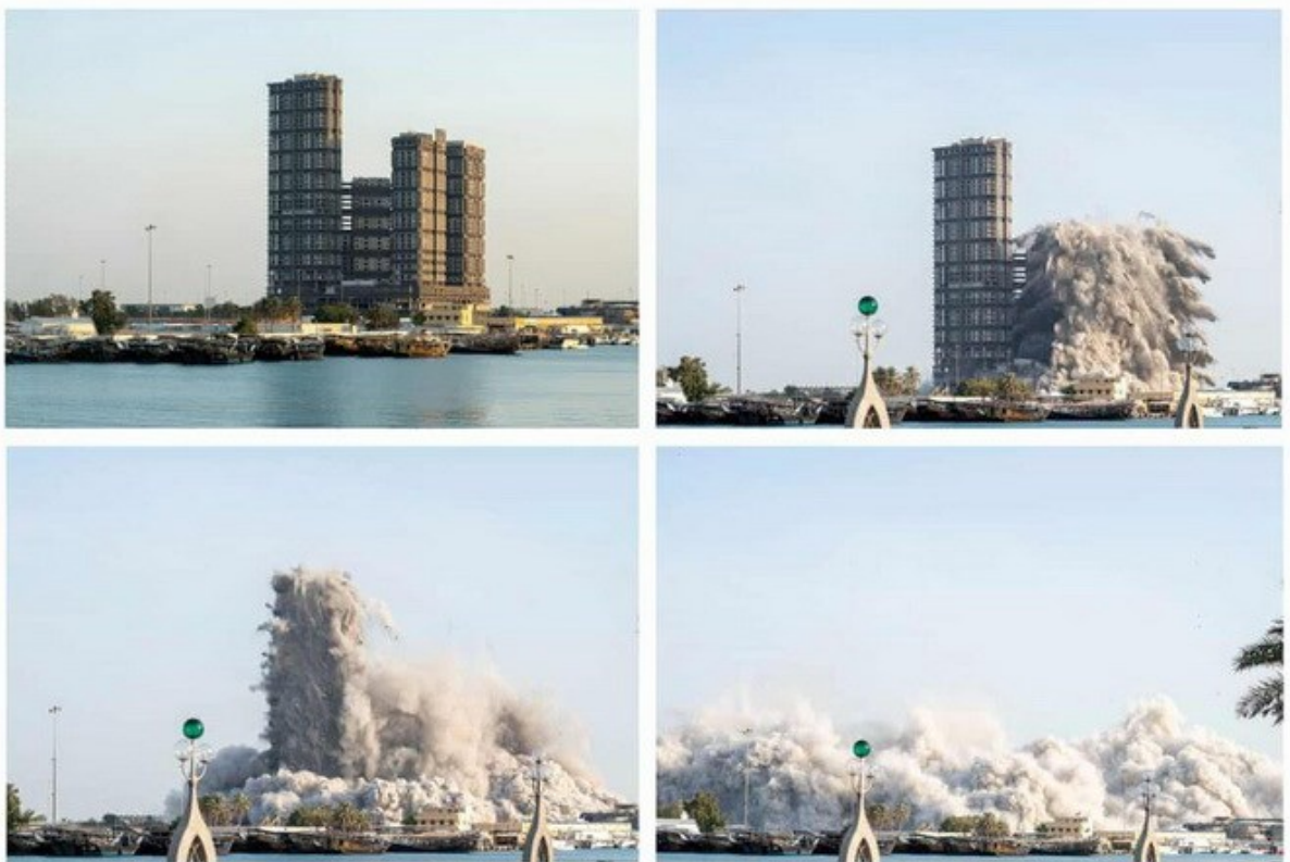
Рисунок 1.8 – Демонтаж будівлі направленим вибухом
