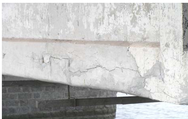
Рис. 3. Дефекты опорных частей
