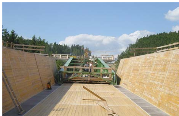
Рис. 3, а. Конструкция опалубки на подмостях
