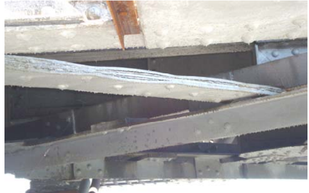
Рис. 4. Дефекты железобетонных и металлических пролетных строений
