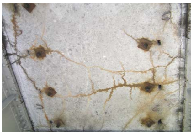
Рис. 1. Излишний балласт, многочисленные трещины по плитам БМП
