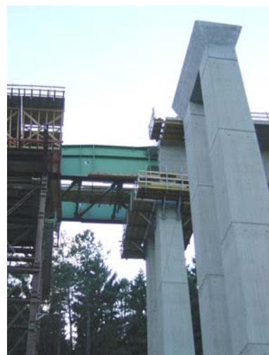
Рис. 3, б. Завод аванбека на опалубку
