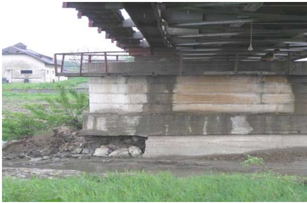
Рис. 5. Критические состояния опор мостов
