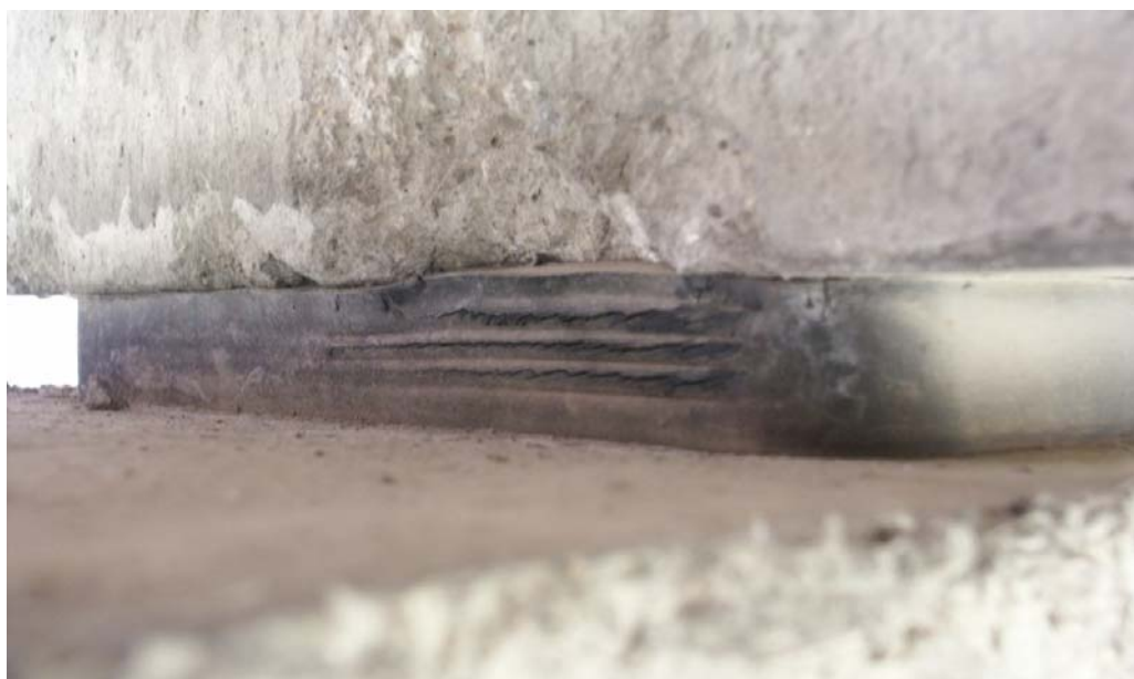
Рис. 3. Дефекти опорних частин:
