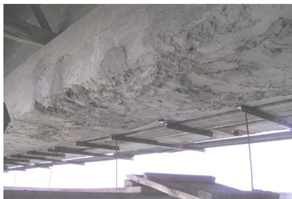
Рис. 2. Дефекты железобетонных и сталежелезобетонных пролетных строений
