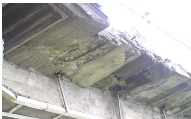
Рис. 3. Дефекты опорных частей
