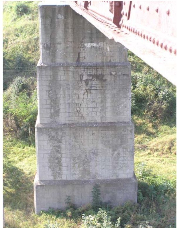
Рис. 4. Дефекты железобетонных и металлических пролетных строений
