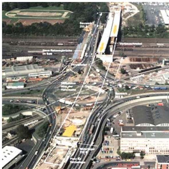
Рис. 6. Встречная надвигка пролетного строения
