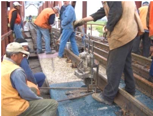
Рис. 4. Монтаж колії на плитах та встановлення локомотиву у характерній точці
