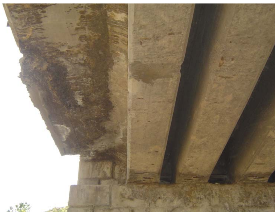
Рис. 1. Железобетонный мост через р. Чартаксай. Выщелачивание бетона и коррозия арматуры в плите проезжей части
