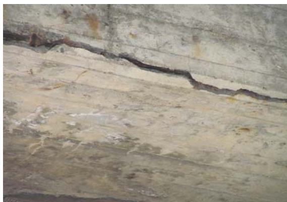
Рис. 2. Дефекты железобетонных и сталежелезобетонных пролетных строений
