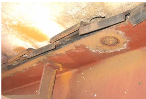
Рис. 1. Излишний балласт, многочисленные трещины по плитам БМП
