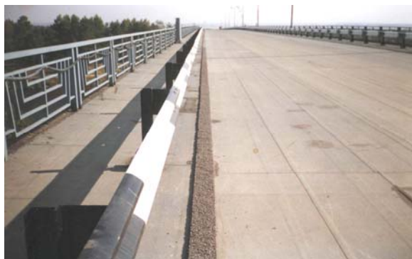
Рис. 3. Дренажный канал на ортотропной плите
