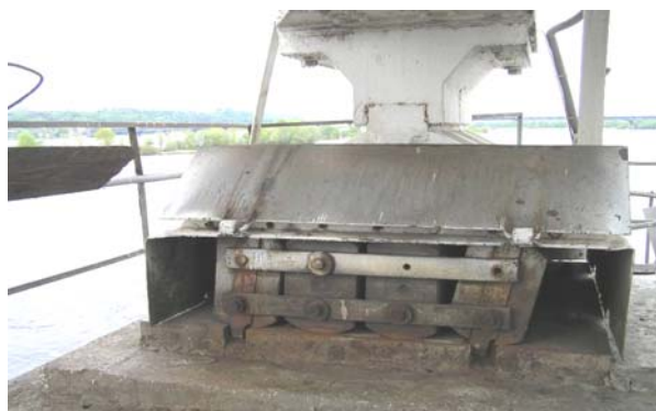
Рис. 3. Дефекты опорных частей
