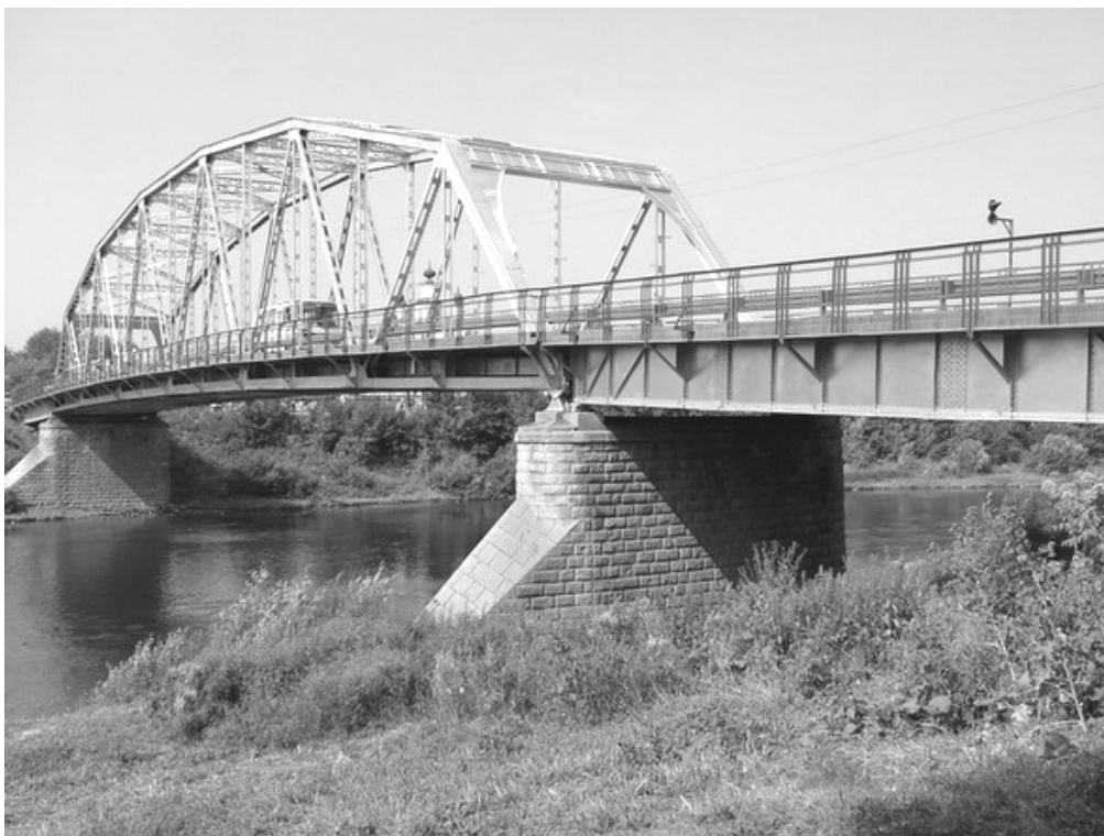
Рис. 1. Общий вид моста после реконструкции
