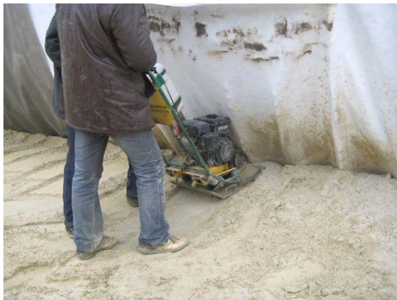
Рис. 1. Пошарове ущільнення ґрунту засипки при влаштуванні металевої гофрованої труби: а – за допомогою спеціальної техніки; б – із застосуванням ручних трамбувальних механізмів
