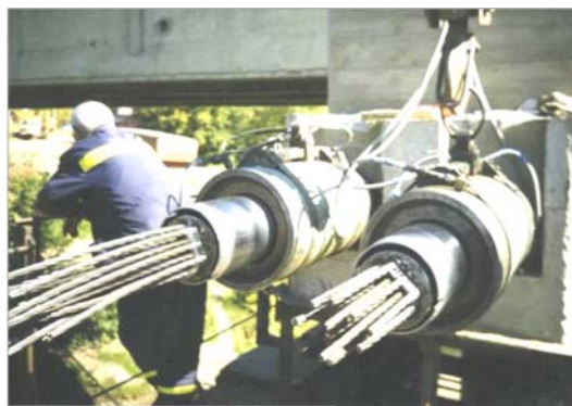
Рис. 3. Натяжение арматурных пучков
