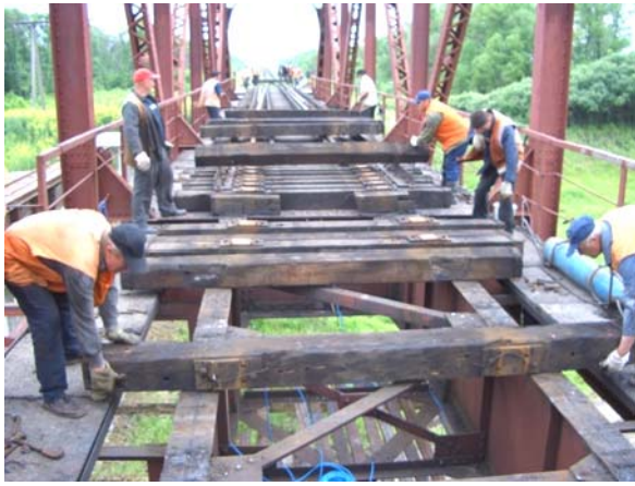
Рис. 3. Демонтаж старого полотна та встановлення мостового полотна на плитах БМП
