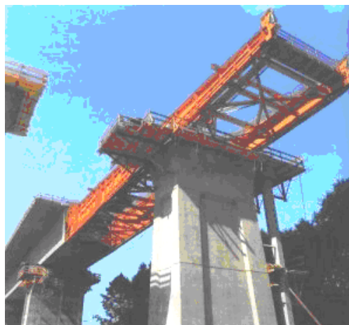
Рис.8. Надвигка пролётного строения длиной 80 м
