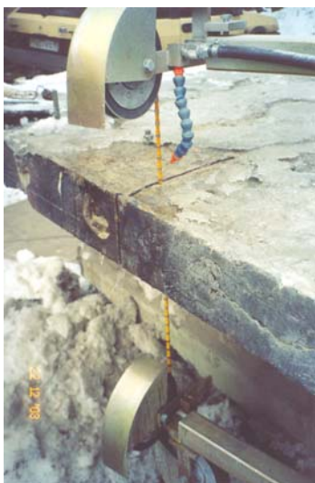
Рис. 6. Разрезание балки алмазным канатом
