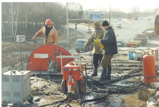
Рис. 5. Первое применение в России алмазной резки на путепроводе через Волоколамское шоссе в г. Москве
