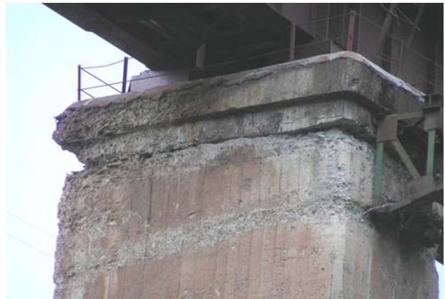
Рис. 5. Критические состояния опор мостов
