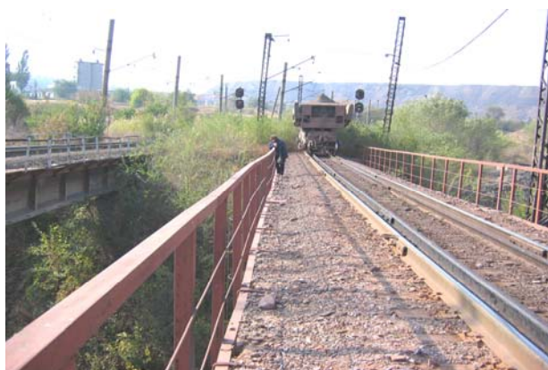
Рис. 1. Излишний балласт, многочисленные трещины по плитам БМП
