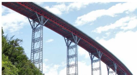
в) міст Ганхайзі (Ganhaizi Bridge)
