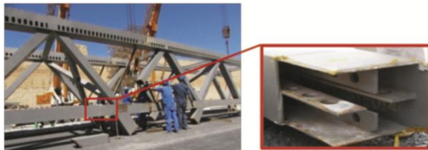
Рис. 7. Реальне застосування посилення ребрами конструкції мосту
