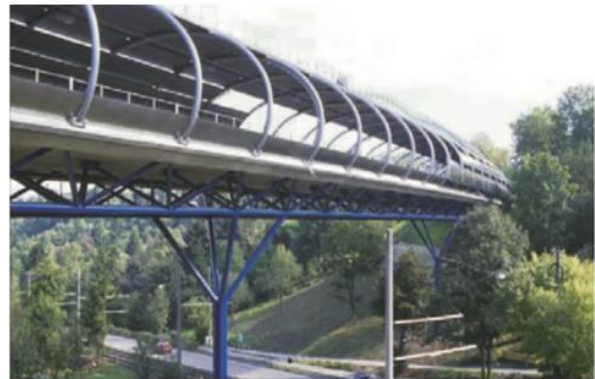
Рис. 3. Вузол об'єднання елементів решітки в нижньому поясі дворівневого пішохідно-автомобільного мосту р. Незенбах (Nesenbach) у Німеччині:
