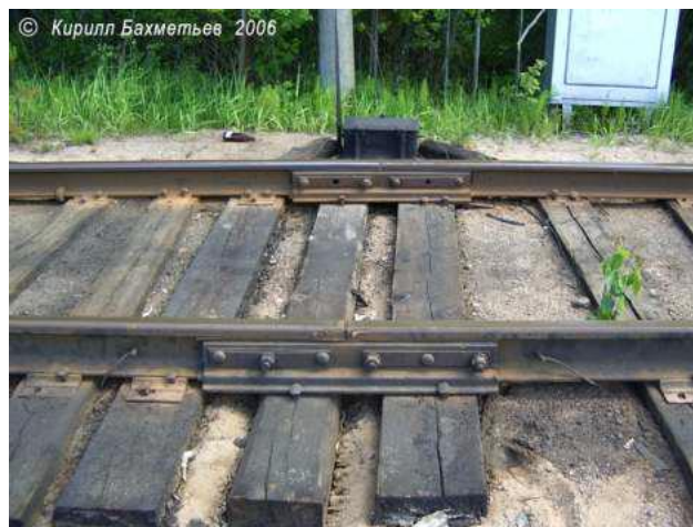
Рисунок 1.3 – Путь на песчаном балласте
