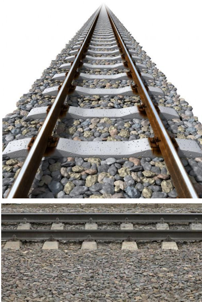
Рисунок 1.1 – Вид железнодорожного пути на щебеночном балласте
