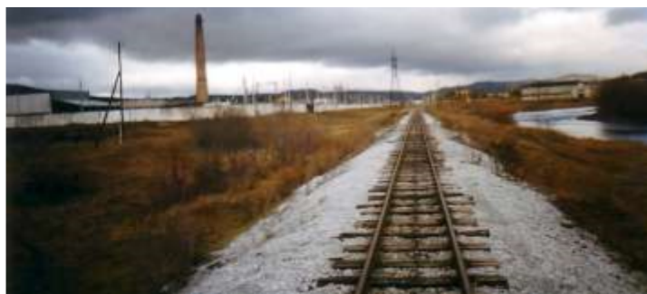
Рисунок 1.2 – Смесь песчано-щебеночных материалов на железнодорожном пути
