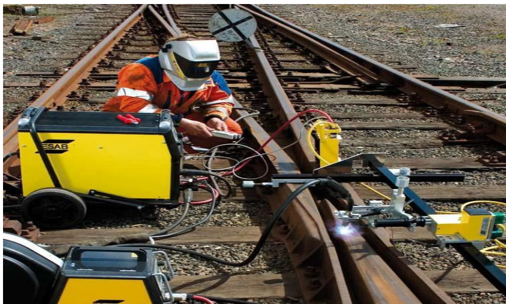
Рисунок 2.6 – ESAB в работе при наплавке крестовины [24]
