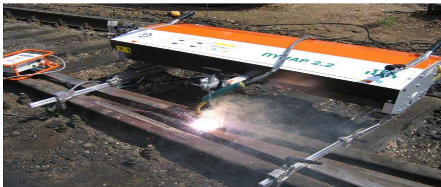
Рисунок 2.8 – Наплавка крестовин автоматом Пунар 2.2 в полевых условиях [26]
