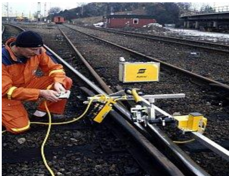
Рисунок 2.7 – Наплавка крестовин с использованием установки Railtrac BV 1000/BVR 1000 [25]
