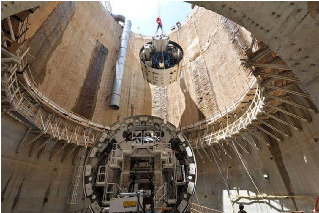
Рис. 14.6. Монтаж щита через шахтний стовбур
