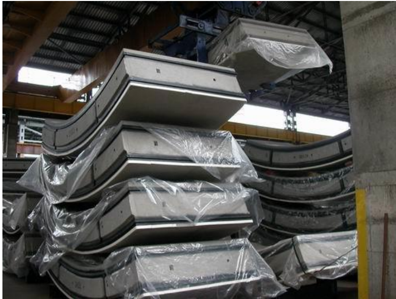
Рис. 4.9. Залізобетонні блоки на складі будівельного майданчику
