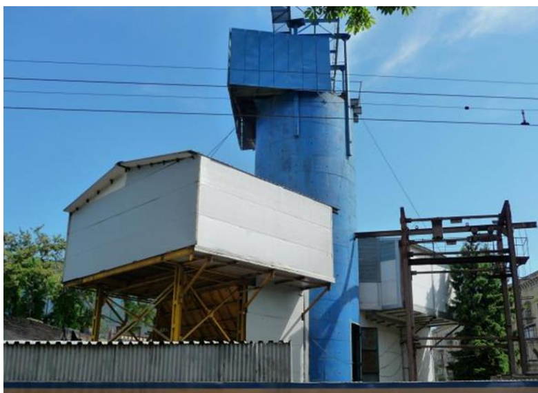
Рис. 14.2. Шахтний стовбур на будівельному майданчику
