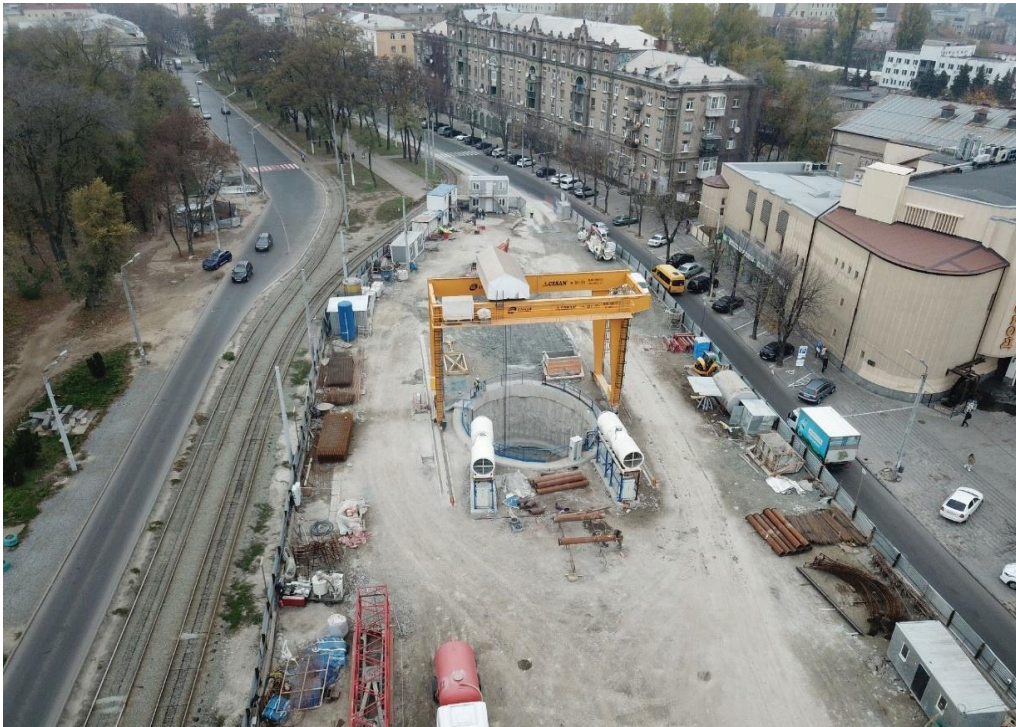
Рис. 14.8. Шахтний стовбур великого діаметру на будівельному майданчику у міських умовах.
