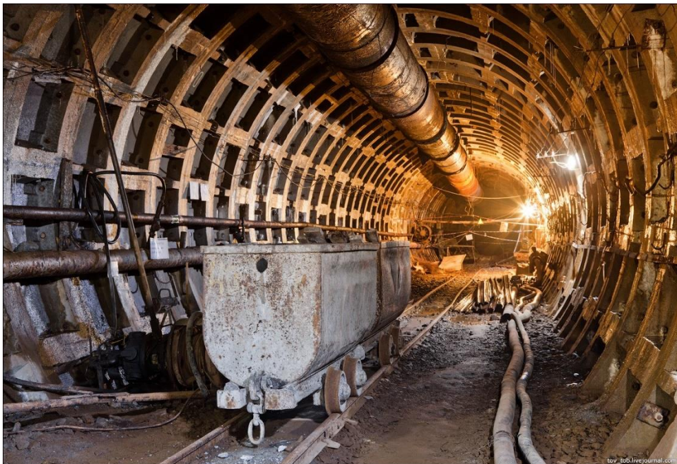
Рис. 3.8. Вид тунельної оправи із залізобетонних тюбінгів
