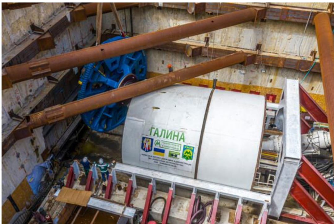
Рис. 14.5. Монтаж щита у котловані (вид з поверхні)
