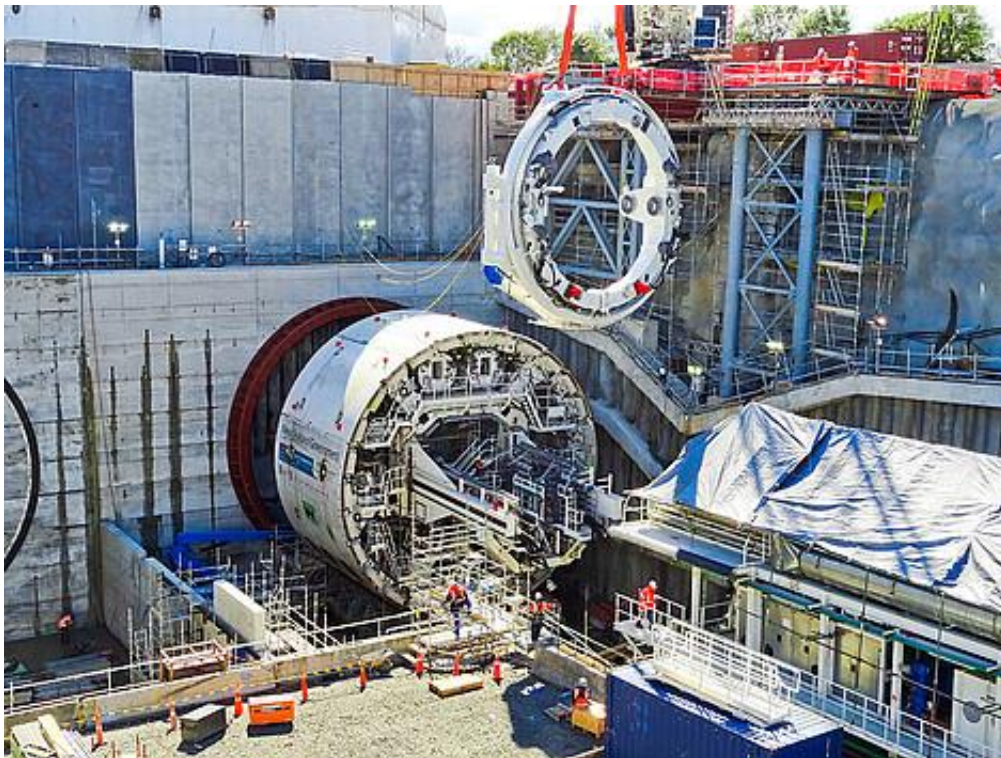
Рис. 14.4. Монтаж щита у котловані (місце введення)
