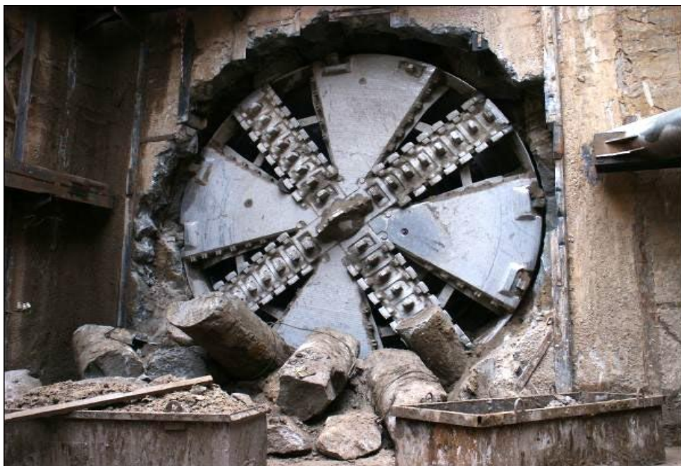
Рис. 13.1. Робочий орган щита роторного типу, оснащений стрижневими різцями
