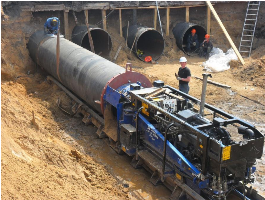
Рисунок 1.3. Установка ГШБ в робочому напрямку з трубою
