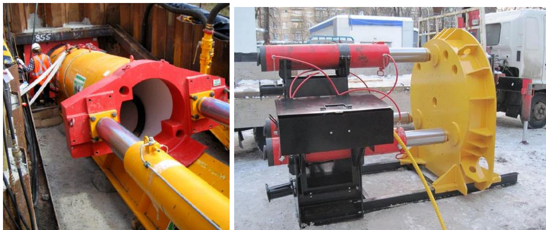
Рисунок 1.5. Статичне продавлювання ґрунту трубою: Загальний вигляд установки, б) – Взаємодія труби з ґрунтом. 1 – гідростанція; 2 – домкратний пристрій; 3 – Опорна площадка; 4 – перехідний стакан; 5 – труба.
