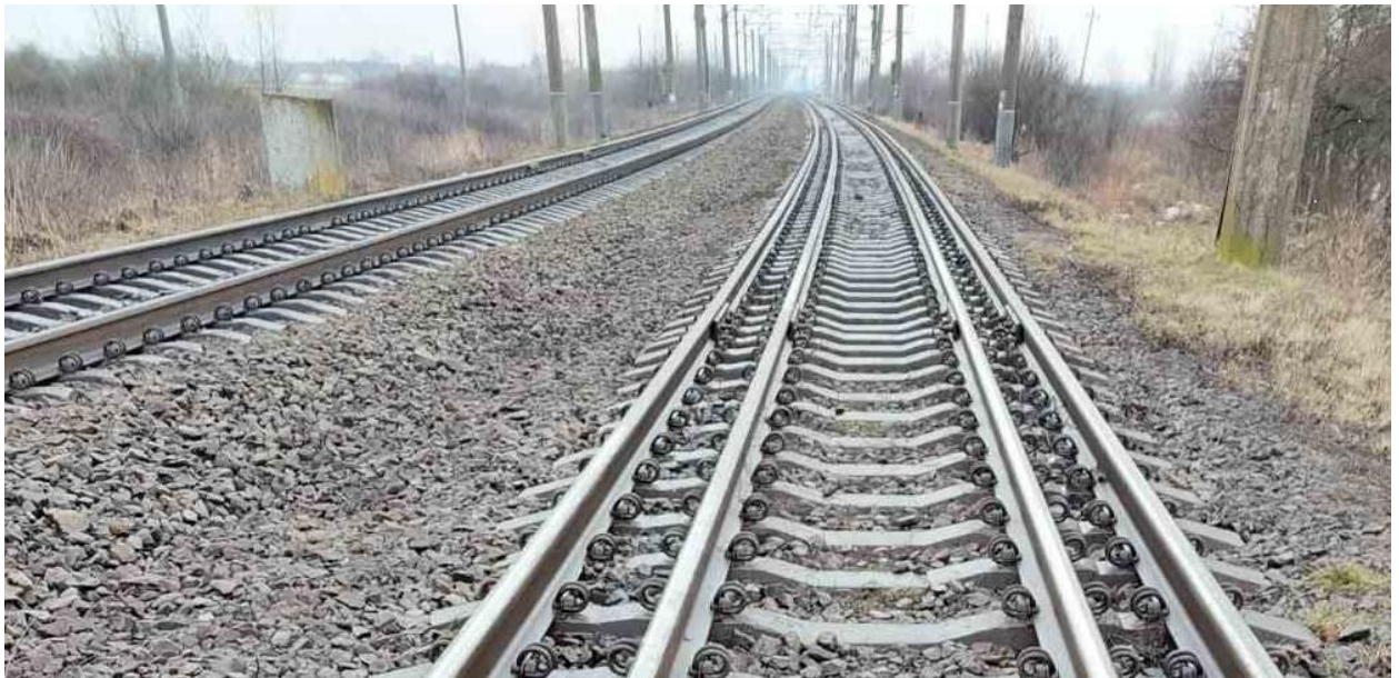
Рисунок 2.2 – Непарна колія 1520 мм, парна 1435/1520 мм
