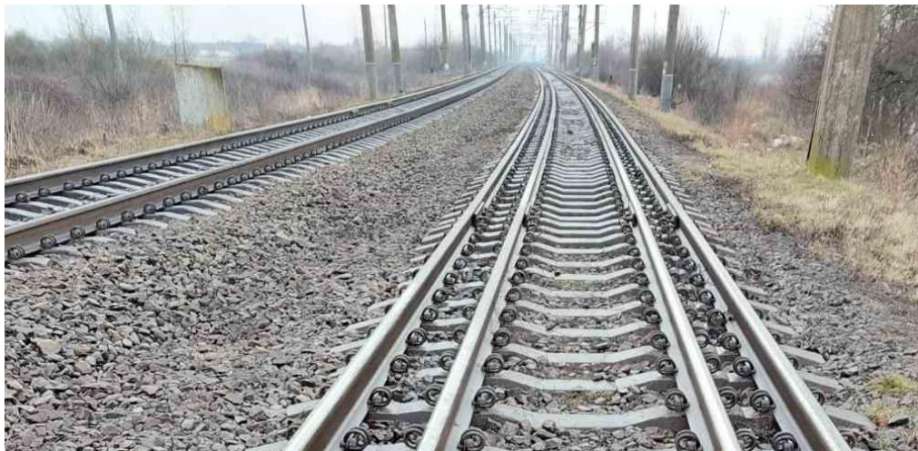
Рисунок 4.2 – Двоколійна ділянка: звичайна колія й суміщена колія
