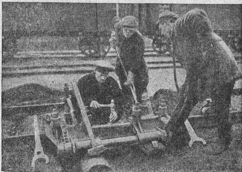
Фиг. 66. Термитная сварка рельсовых стыков.
