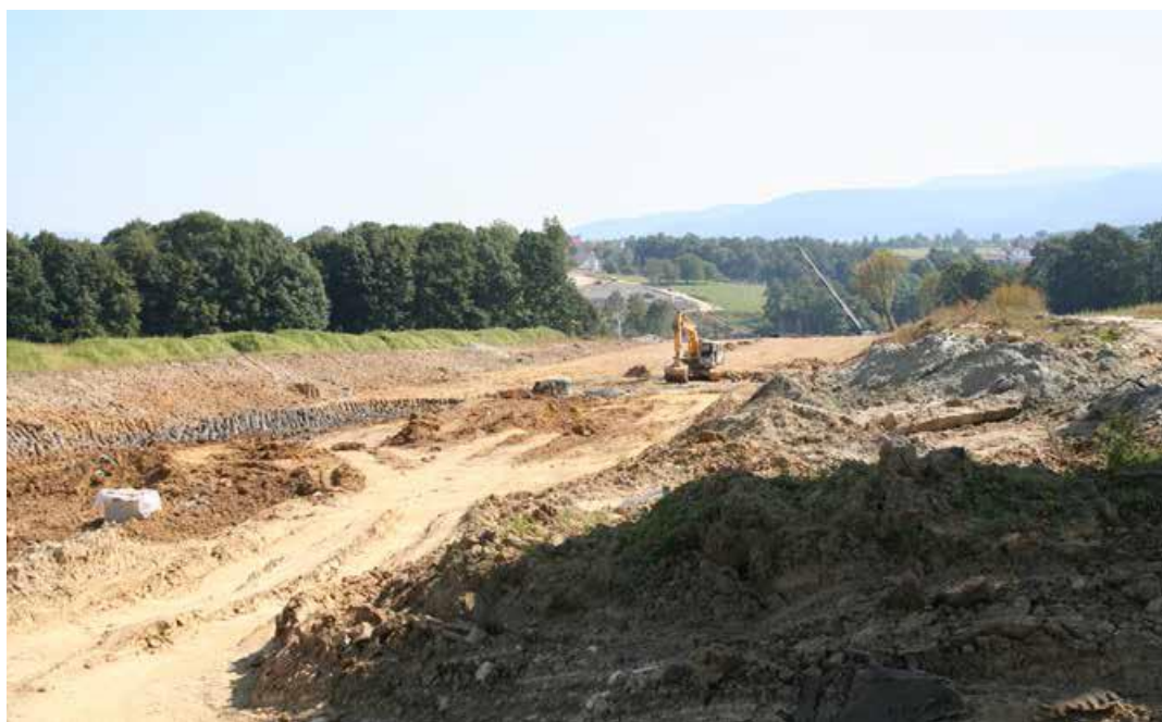
Рисунок 4.1 – Земляні роботи при будівництві автодороги
