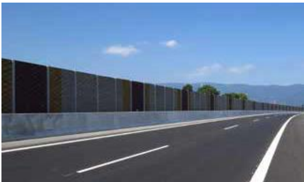
Рисунок 4.9 – Стіна вздовж автомагістралі для захисту від шуму
