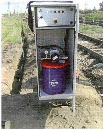
Рисунок 3.19 – Змащувальний блок та змащувальна шина
