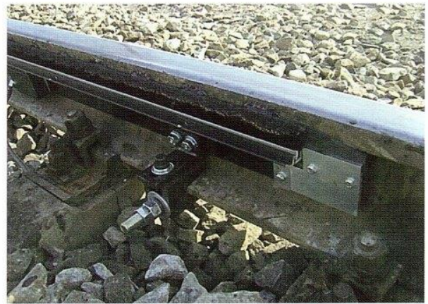
Рисунок 3.19 – Змащувальний блок та змащувальна шина
