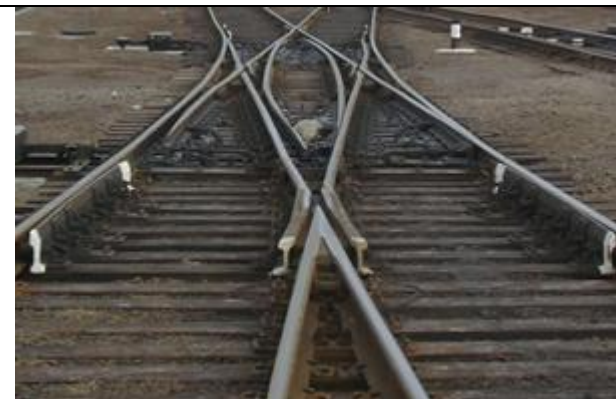
Рисунок 1.6. – Перехрестний стрілочний перевід
