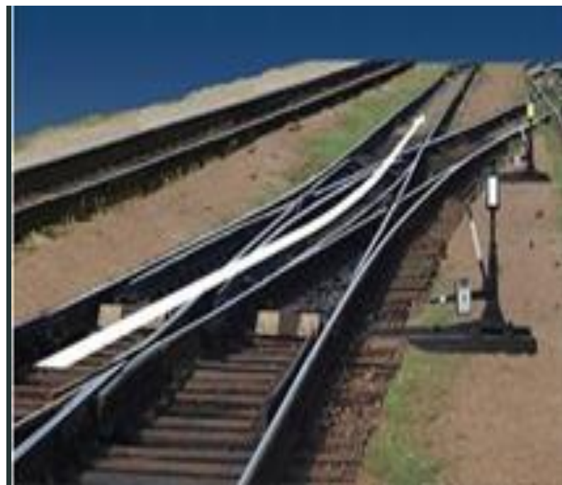
Рисунок 1.7 - Напрями руху перехресним стрілочним переводом
