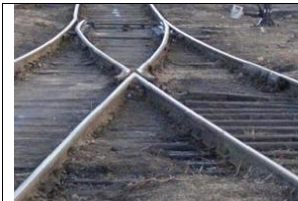
Рисунок 1.5 – Симетричний стрілочний перевід
