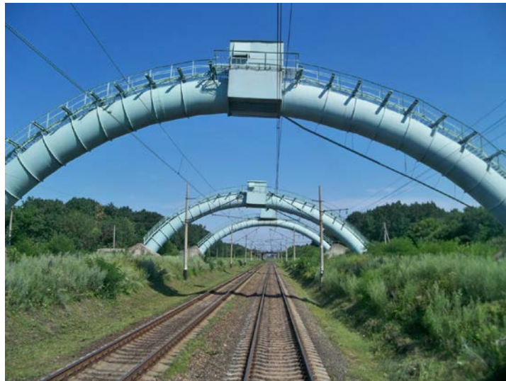
Трубопровід над залізничним полотном (фото)
